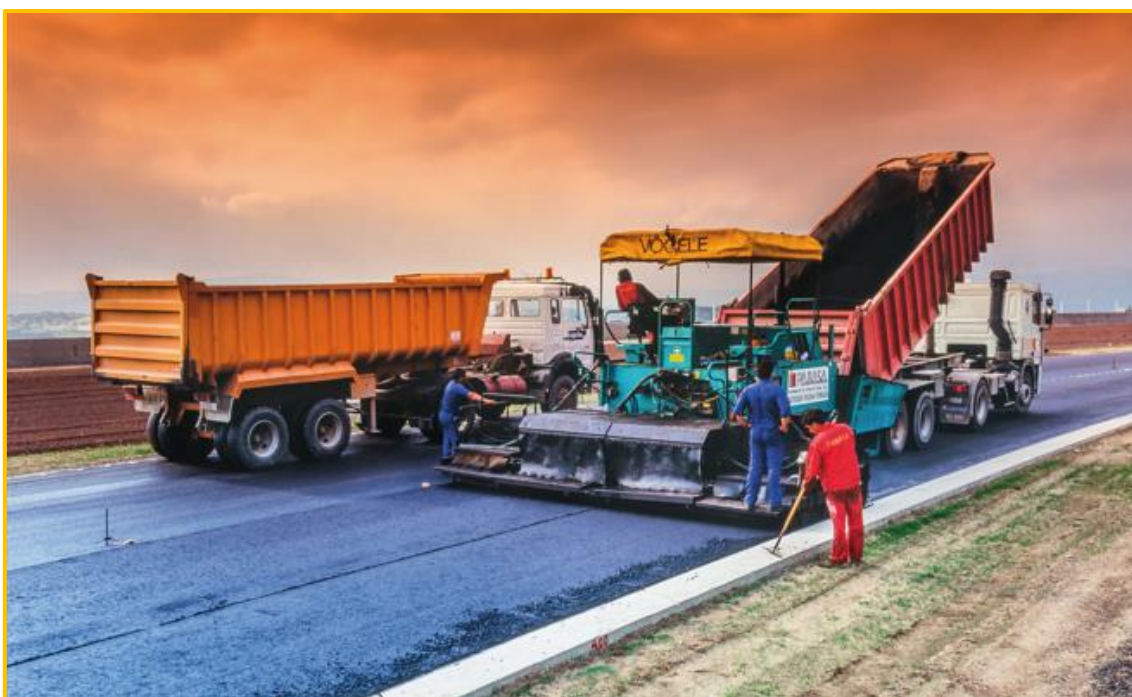
1990 Obres d'asfaltat de la pista. Las obras de construcción del Circuito duraron menos de tres años y fueron a un ritmo frenético.
