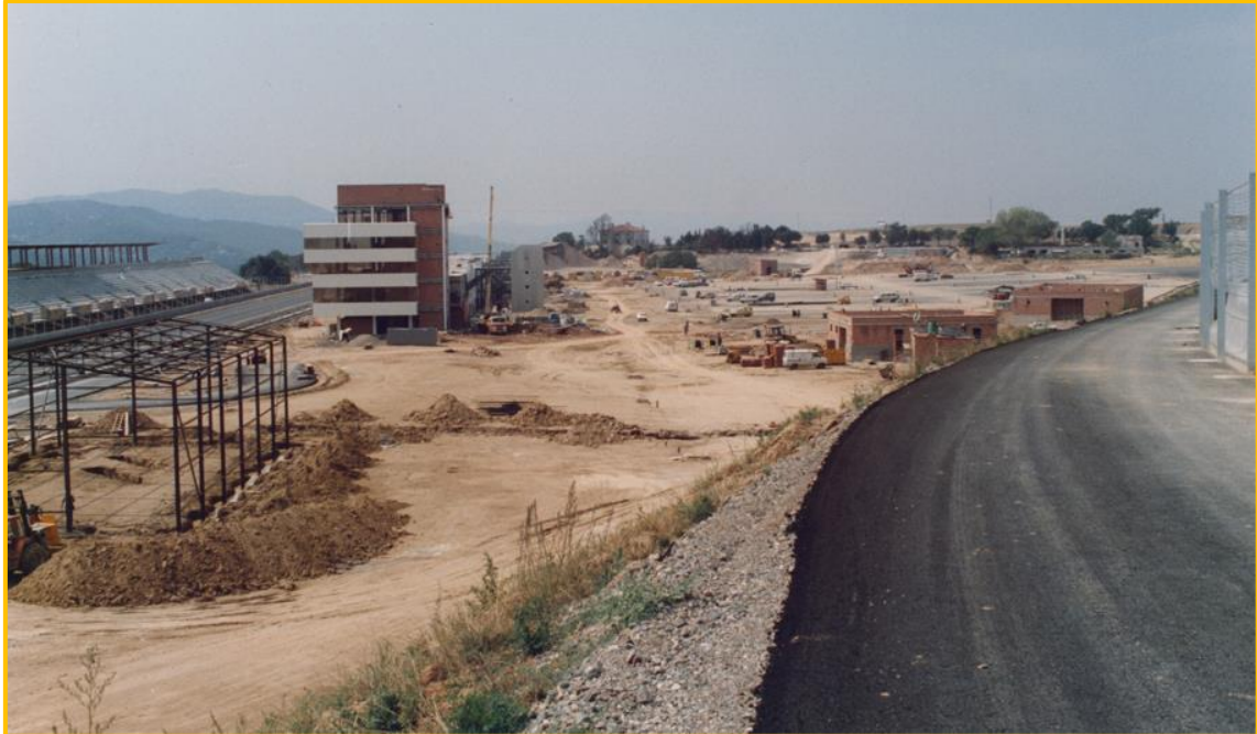
1991 Obres. Proceso de asfaltado. A la izquierda de la imagen, la tribuna y la torre de control van tomando forma a ambos lados de la recta principal,
